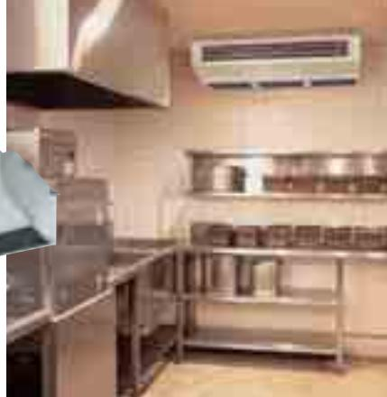
Standardna oprema uključuje karbonsko kućište od nehrđajućeg čelika i uljni filter koji sprječava ulazak ulja unutar jedinice omogućavajući ugodnu klimatizaciju u kuhinjama s otvorenim plamenom.
